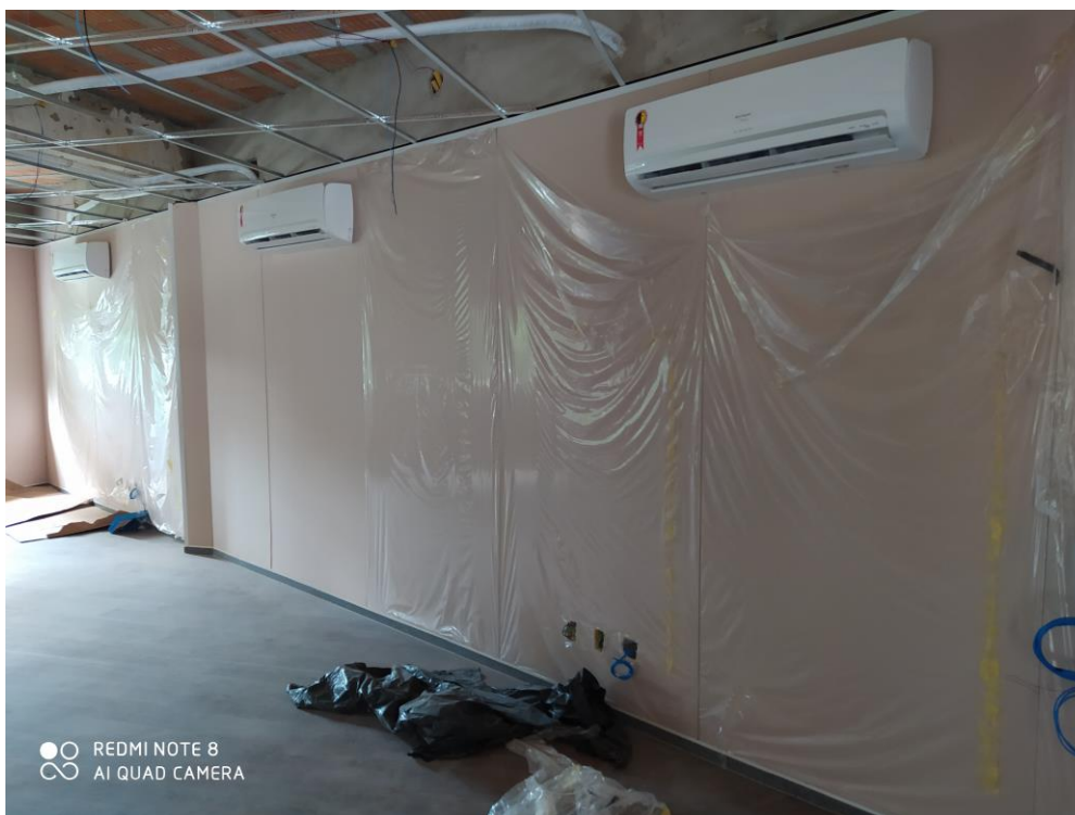
Foto 2: Acompanhamento à montagem do Laboratório de Artes Integradas
