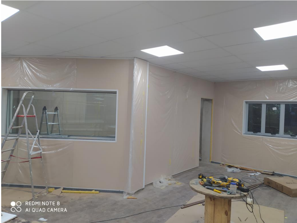
Foto 3: Vistoria à instalação do tratamento acústico do Laboratório de Artes Integradas
